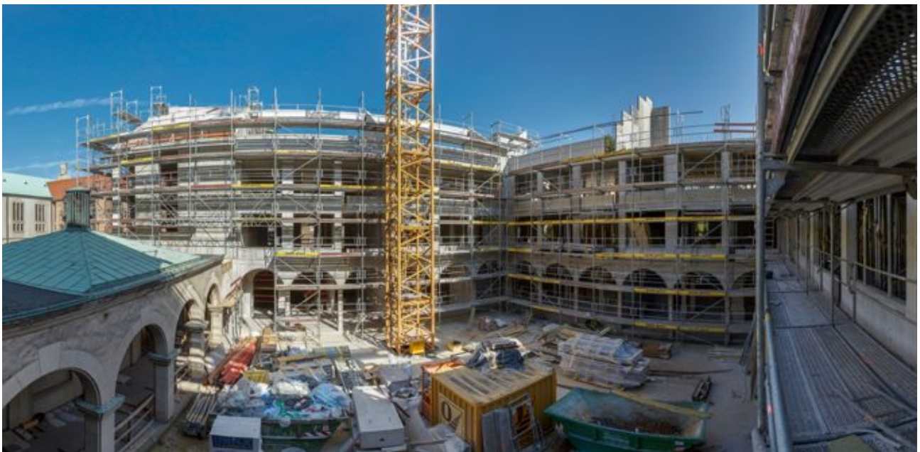
Auch schon wieder Geschichte sind diese beiden Baustellenbilder. In Kürze werden die 23 fertiggestellten Wohnungen der Clemensbögen in Münster den Erwerbern übergeben.
