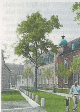
Blick auf den sanierten Neubau an der Servatiikirche.
