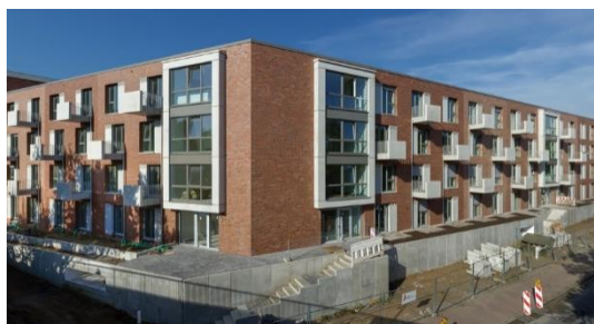
Die ersten 132 von 240 neuen Wohnungen im Erpho-Bogen am Niedersachsenring sind bezugsfertig.
